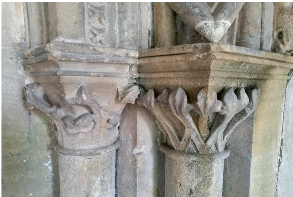
Fig. 21. West door jamb shaft capitals.
